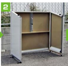
側板-後板セットを開いて設置します。
